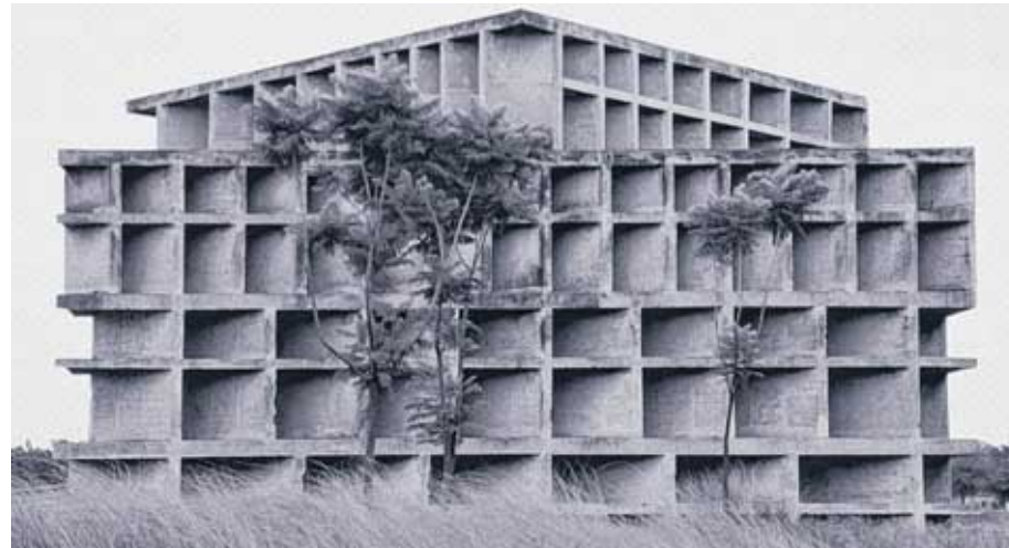
Eine mehrerer Aufnahmen von Bauten Le Corbusiers in Chandigarh.
