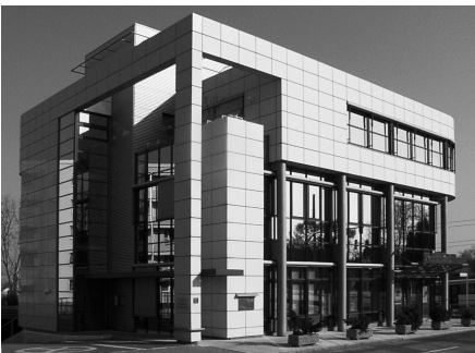
Zu den anspruchsvollsten unter den neueren Chemnitzer Bauwerken gehört die SchmidtBank-Filiale an der Irkutsker Straße. Entworfen wurde sie vom Stuttgarter Büro Bertsch/Friedrich/Kalcher.
